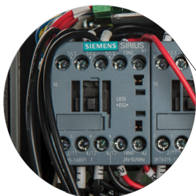
SIEMENS besturingssysteem / SIEMENS relais
